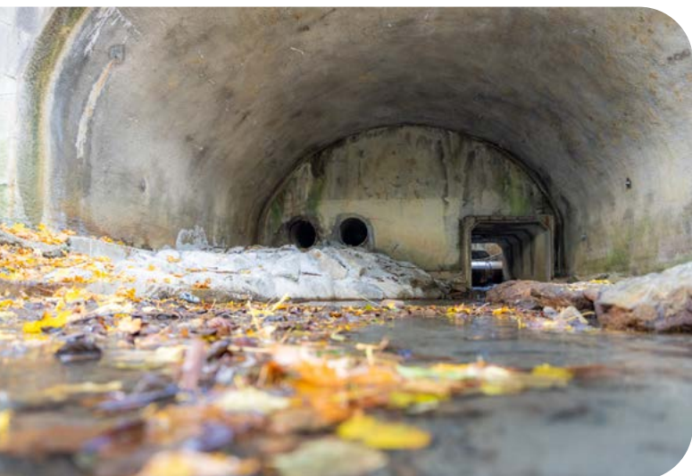
Rampe construite afin de faciliter le passage du castor
