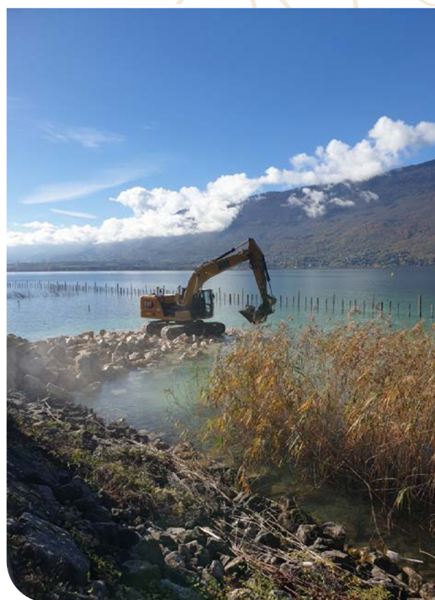
Rechargement en matériaux avant plantation
