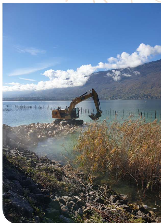
Rechargement en matériaux avant plantation
