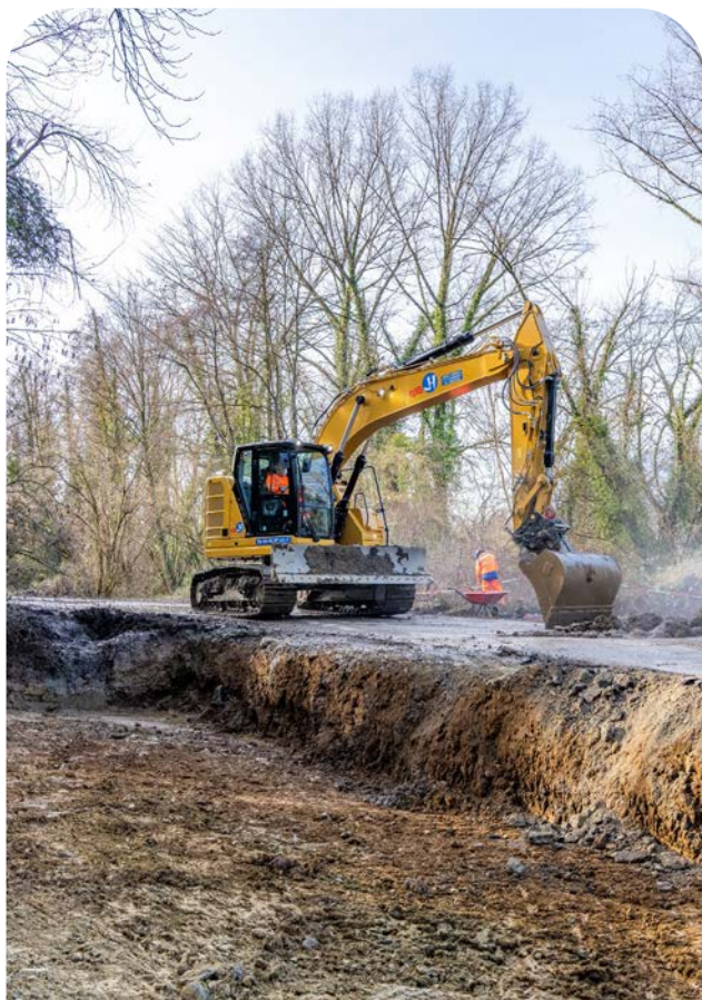
Déconstruction de la route, sur le site de la Fontaine des Janon
