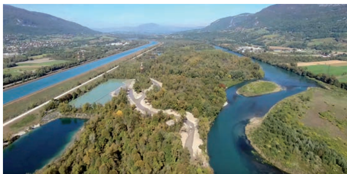
Travaux de raccordement au Rhône du casier n°9 de Malourdie
