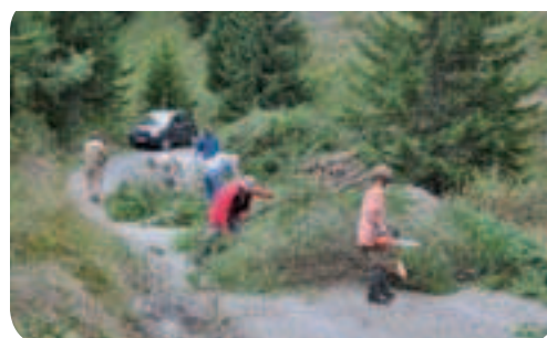
Lors du chantier bénévole à Bozel
