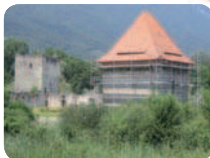
Tour du château de Thomas II durant les travaux de 2007
