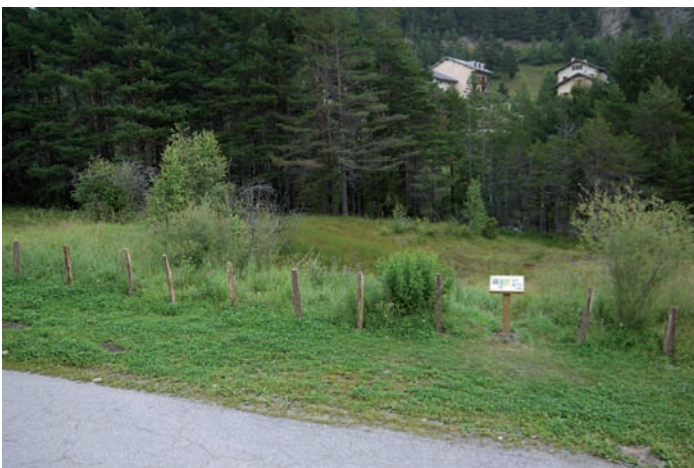
Pose des piquets anti-intrusion aux Arcannes
