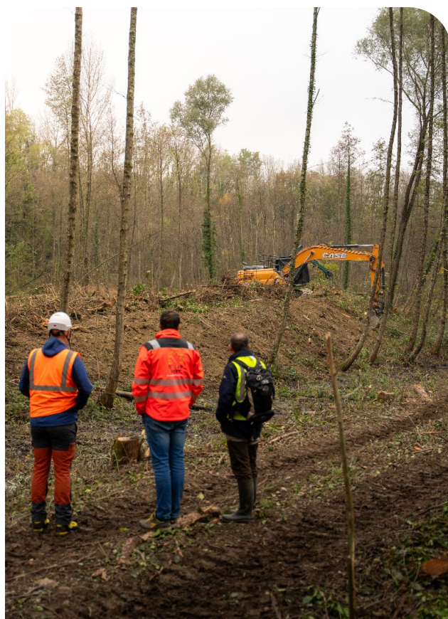
Dessouchage d'arbres afin de préparer la reconnexion des casiers de décantation à la zone humide située en aval (travaux prévus en 2025).
