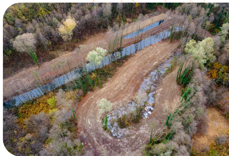
Travaux autour des casiers de décantation, phase initiale de renaturation.
