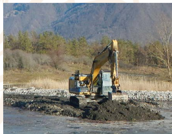
Le travail de la pelleteuse afin d'enfouir les rhizomes de renouée du Japon, travaux réalisés dans le cadre du projet RestHALp.
